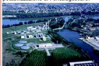
centrale di Pontelagoscuro
