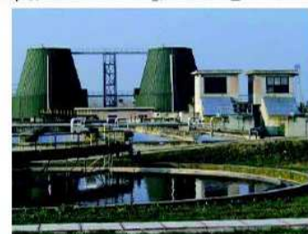
impianto di depurazione
